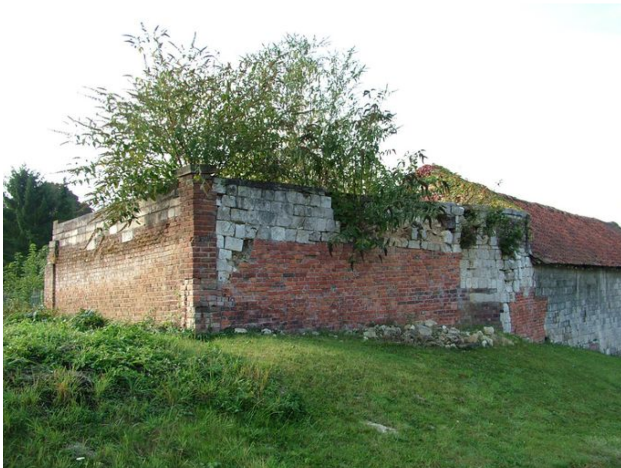
Vestiges de l'ancien corps d'entrée.
