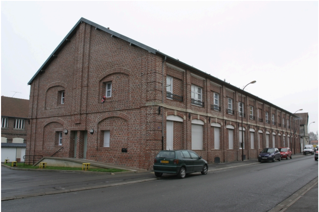
Atelier de tulle : façade antérieure.
