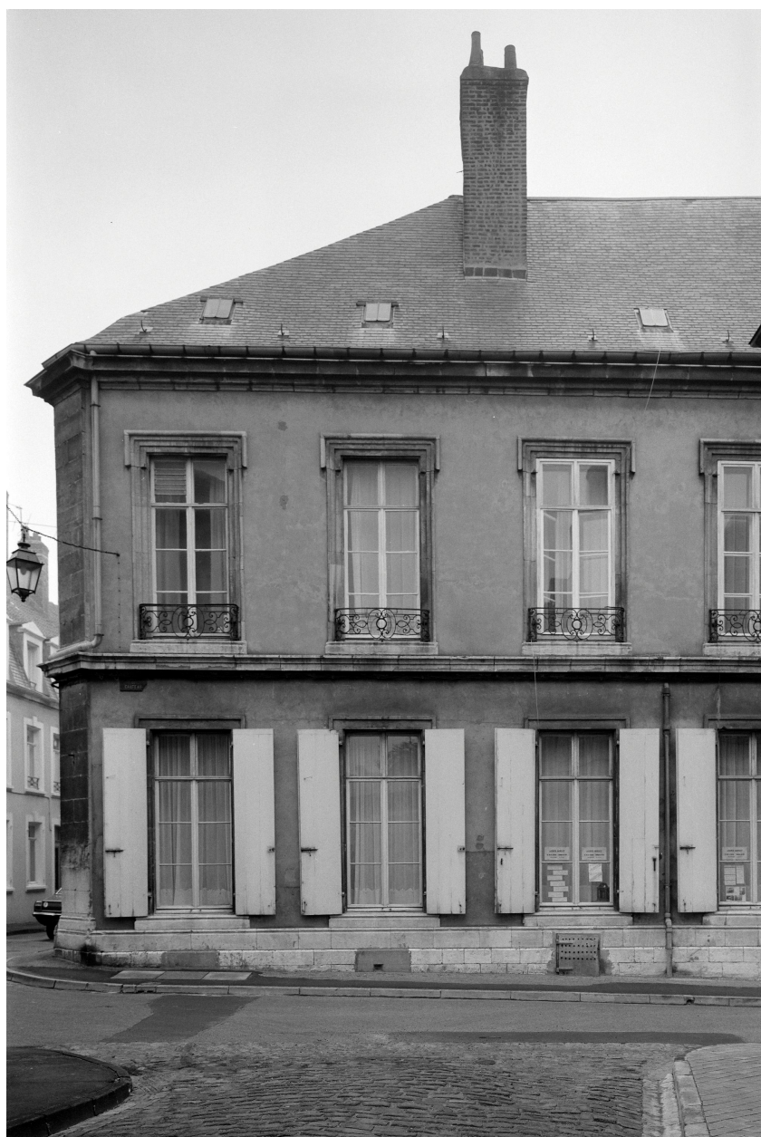
Façade, rue du Château, détail.
