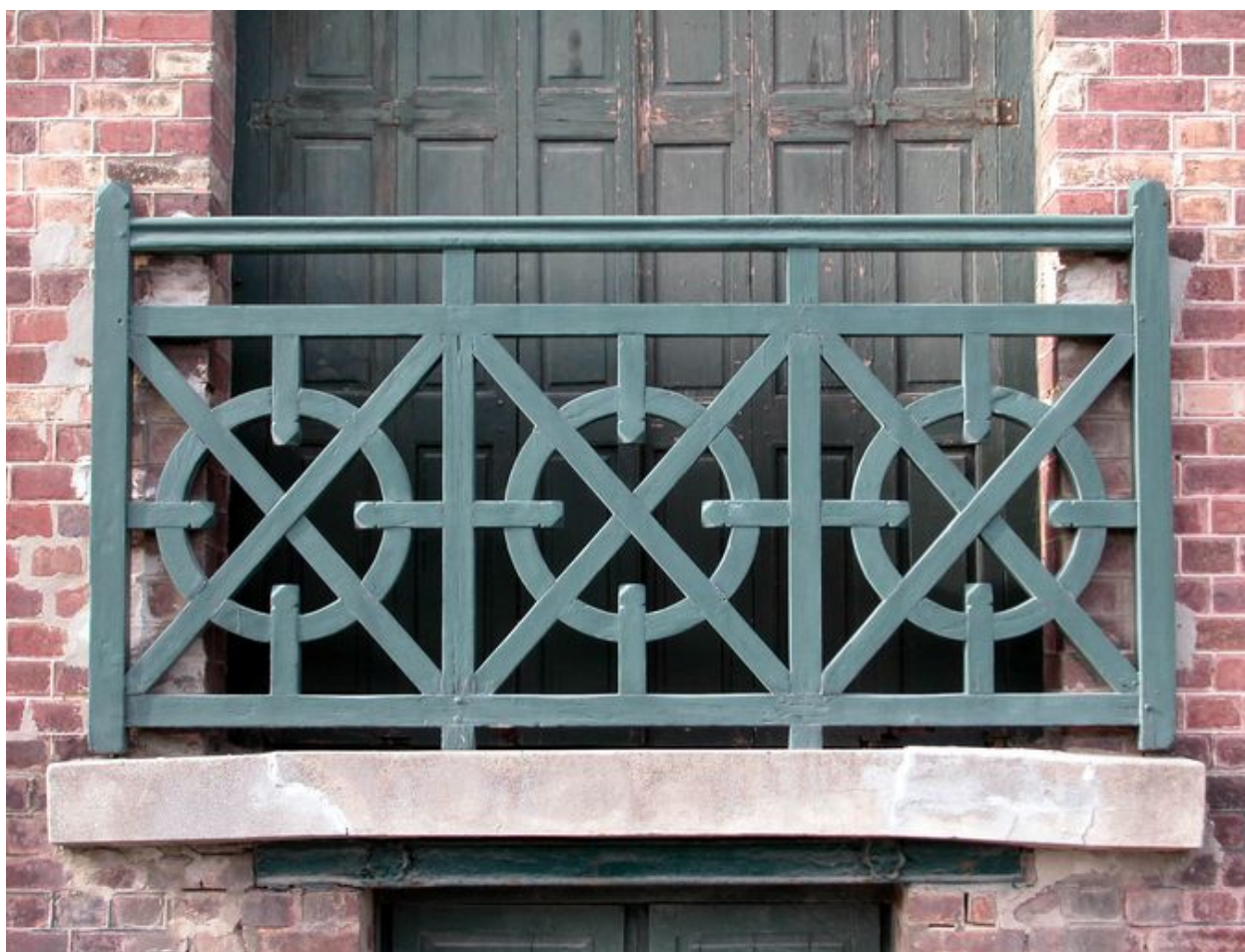
Détail du balconnet en menuiserie du rez-de-chaussée.
