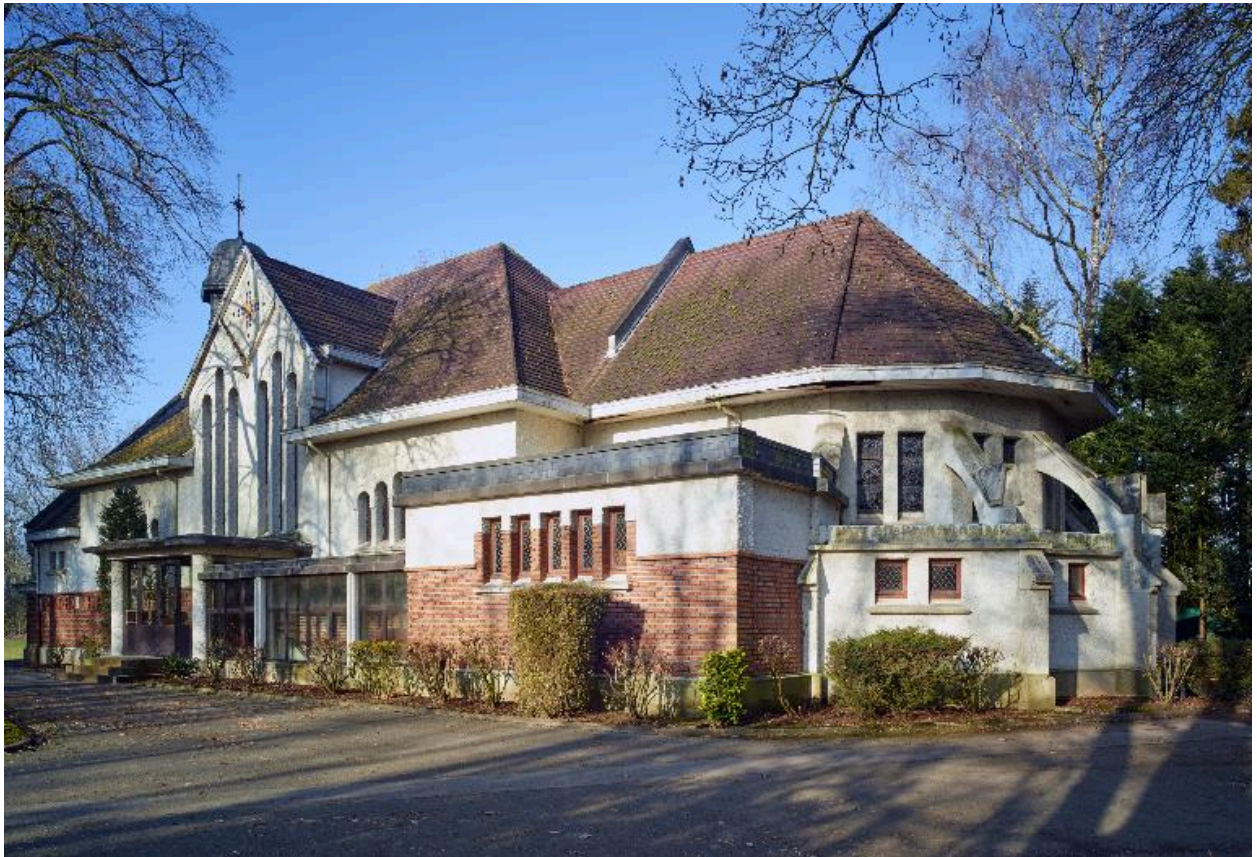
Chapelle, élévation latérale sud ou droite, vue de trois quarts droit.
