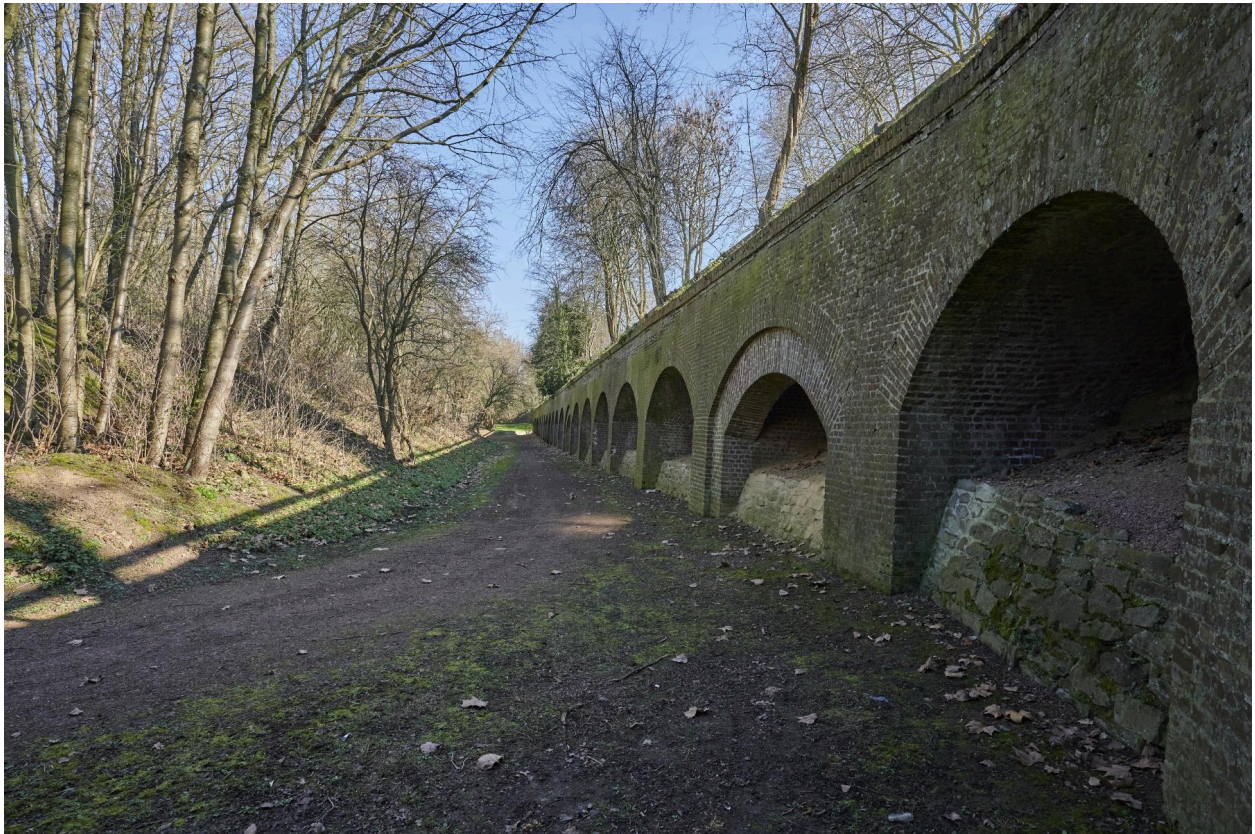
Fossé sud-est. Au fond la caponnière simple.
