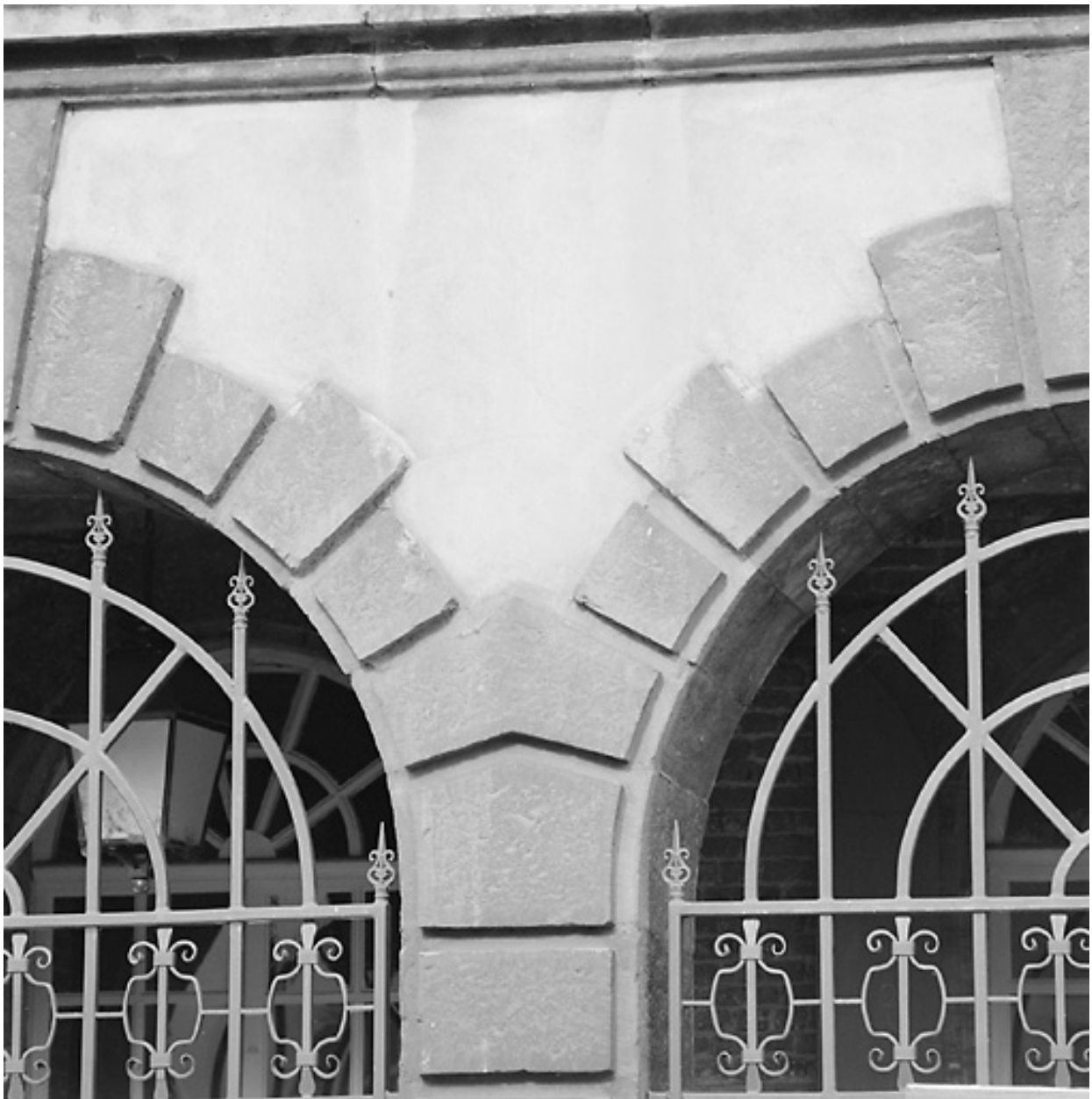
Corps de garde, façade, rez-de-chaussée, détail : encadrement des baies en bossage à table plate.
