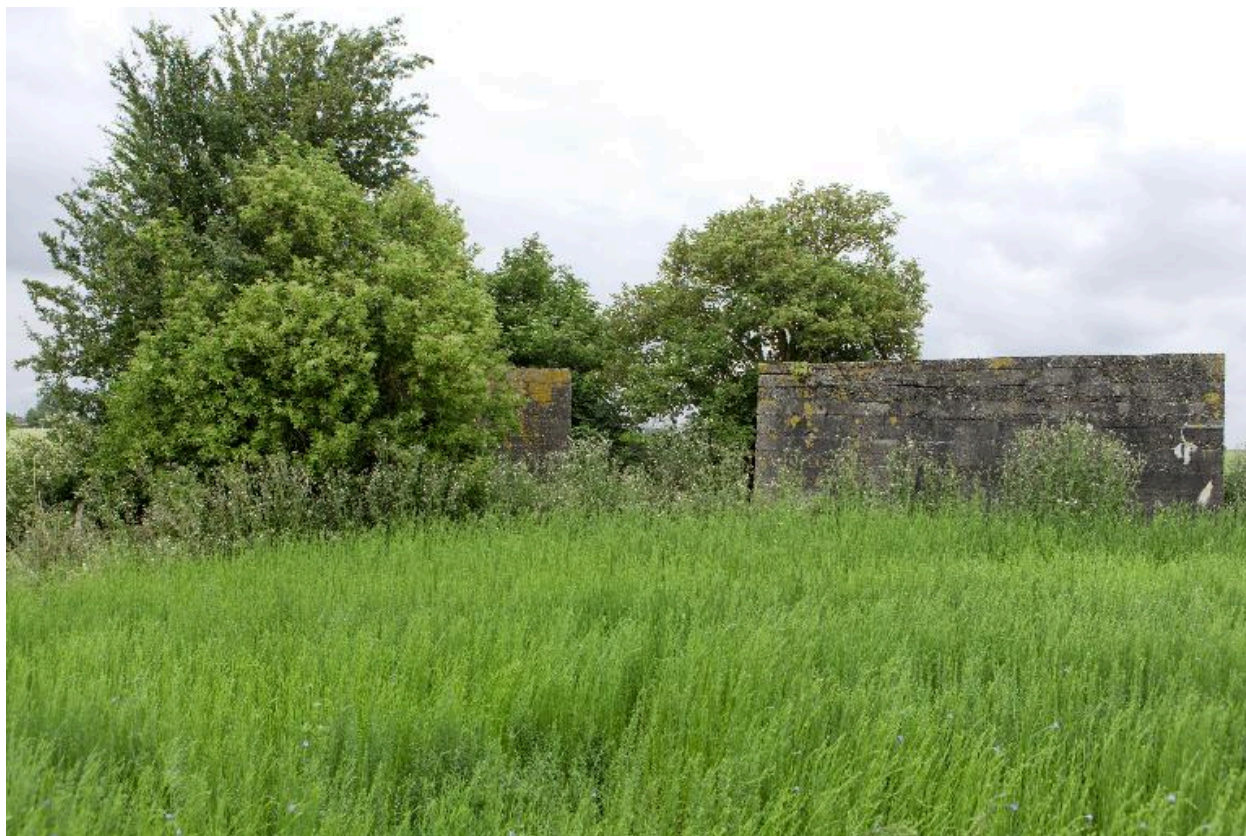
De droite à gauche, les bâtiments 1 et 2, vers l'est
