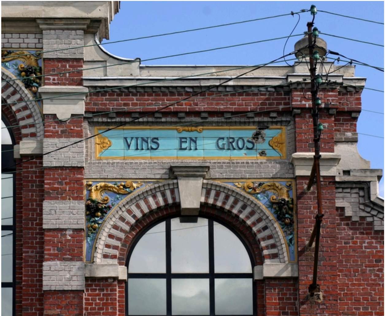
Façade antérieure, détail.
