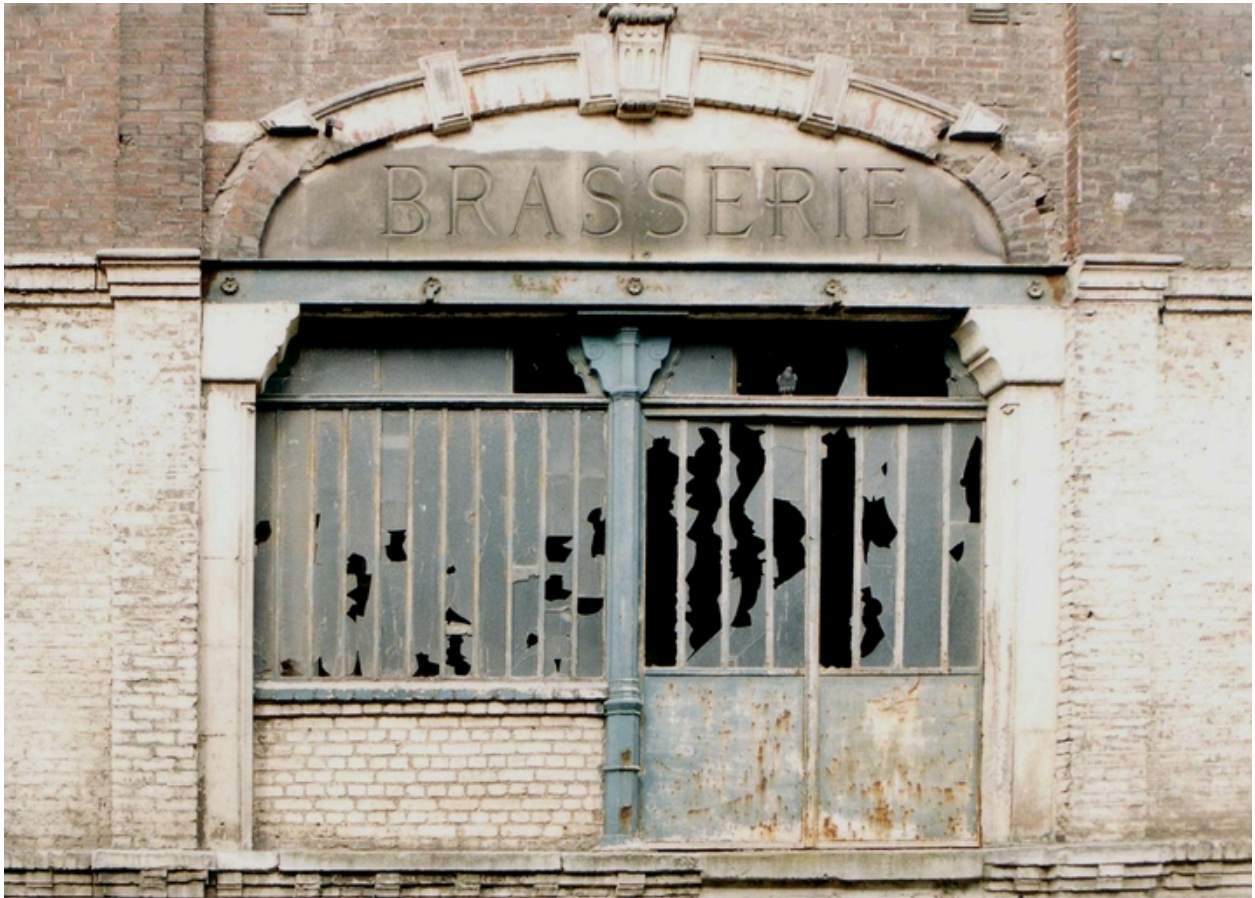
Détail de la façade sur rue, 1996 (BM Saint-Quentin).
