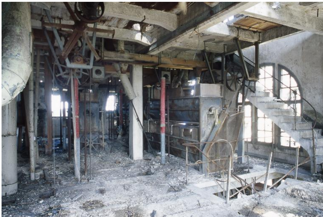
Bâtiment du nettoyage. Rez-de-chaussée.
