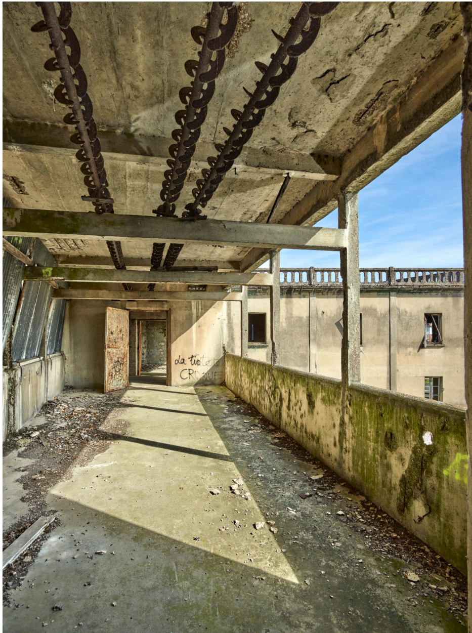
Passerelle reliant les deux corps de bâtiments de la minoterie.
