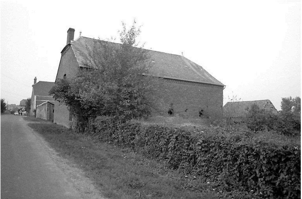
Elévation postérieure de l'étable.
