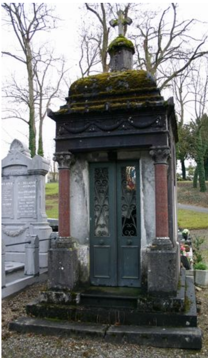
Vue générale du tombeau-chapelle.
