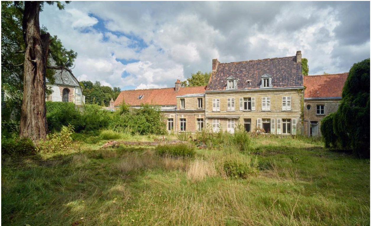
Ferme des berceaux en 2018 : laiterie, logement patronal et remise (partie ouest de la ferme) : vue générale des façades arrières depuis le jardin.
