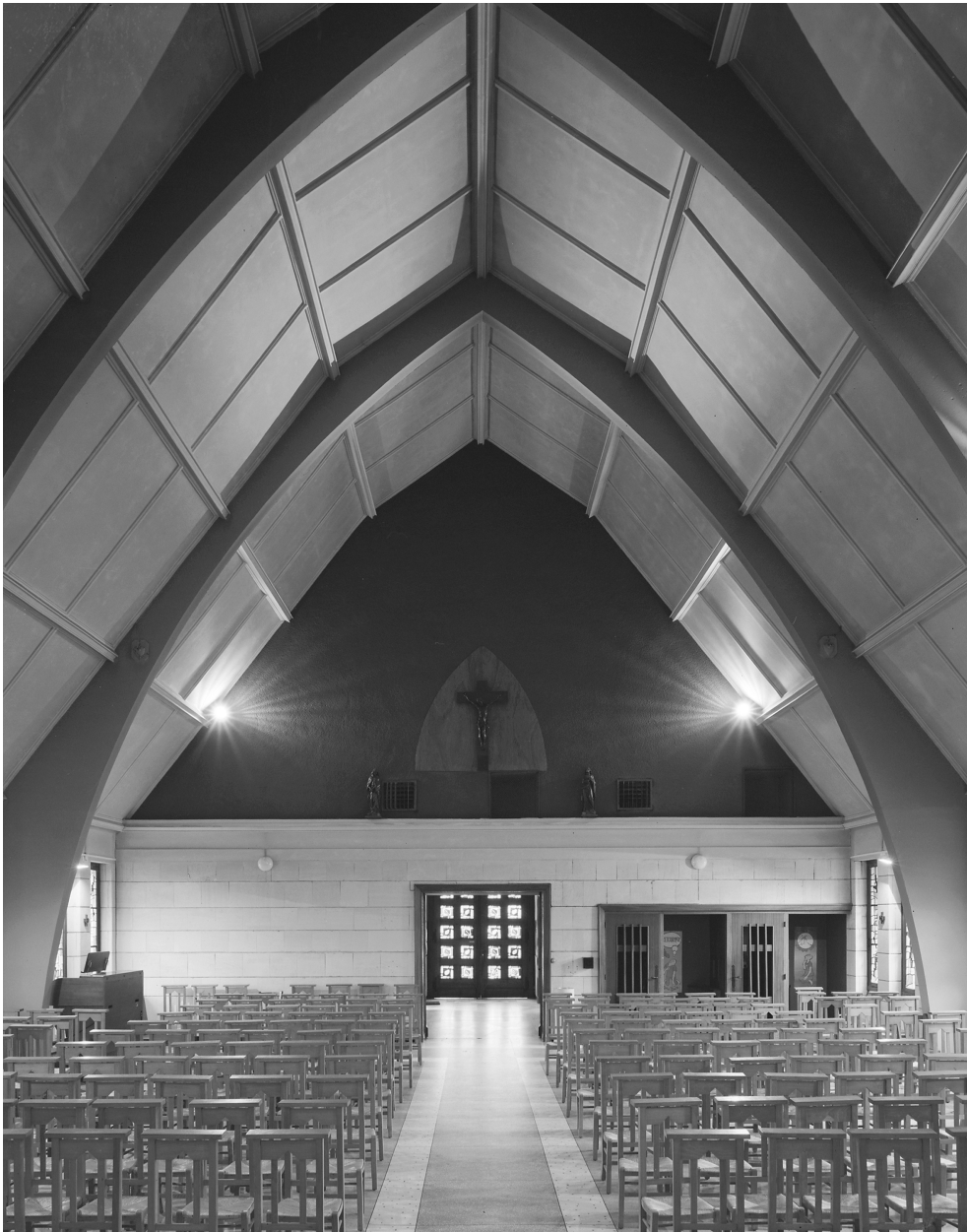
Chapelle du Saint Sacrement, vue intérieure vers entrée.
