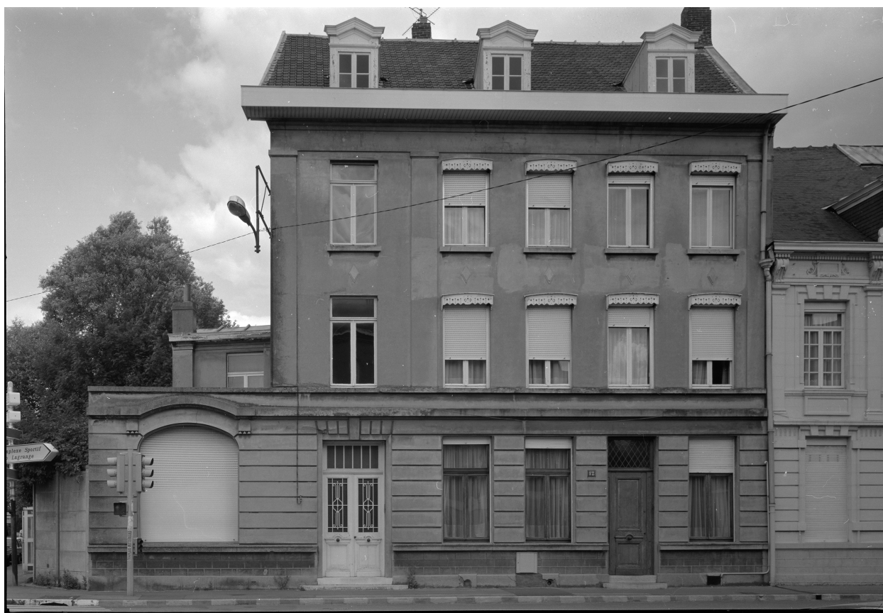
Anciens bureaux et portail d'entrée.
