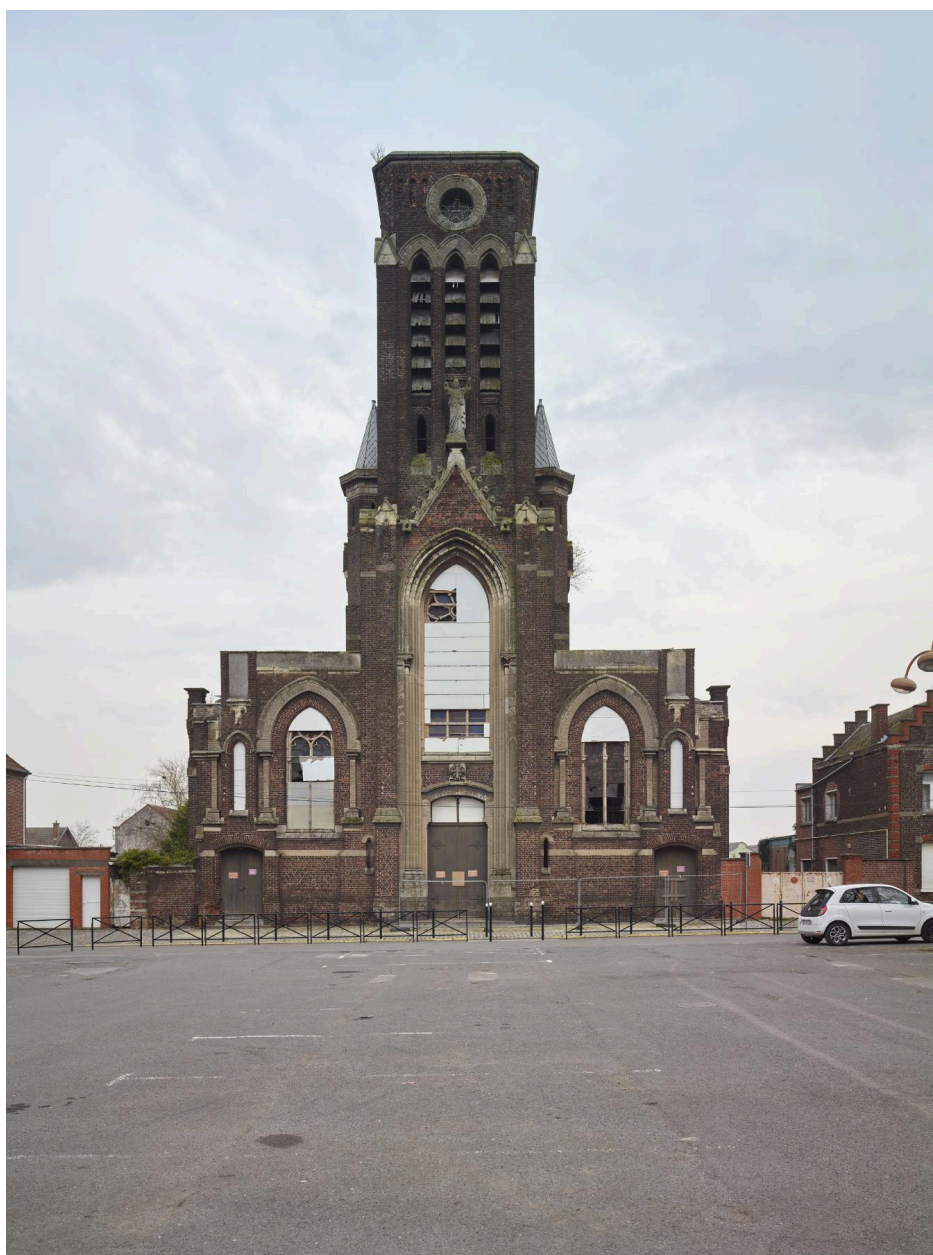
Vue générale de la façade sud-ouest de l'église.
