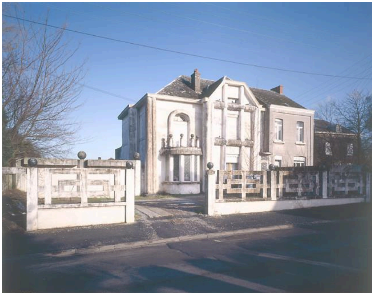
Élévation antérieure depuis la rue.
