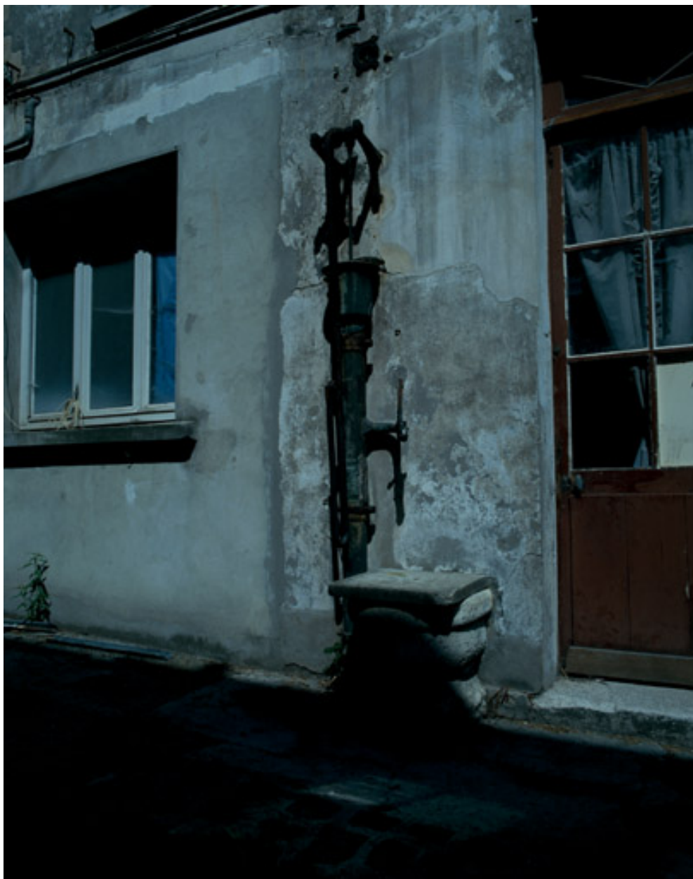
Pompe à eau dans la cour.
