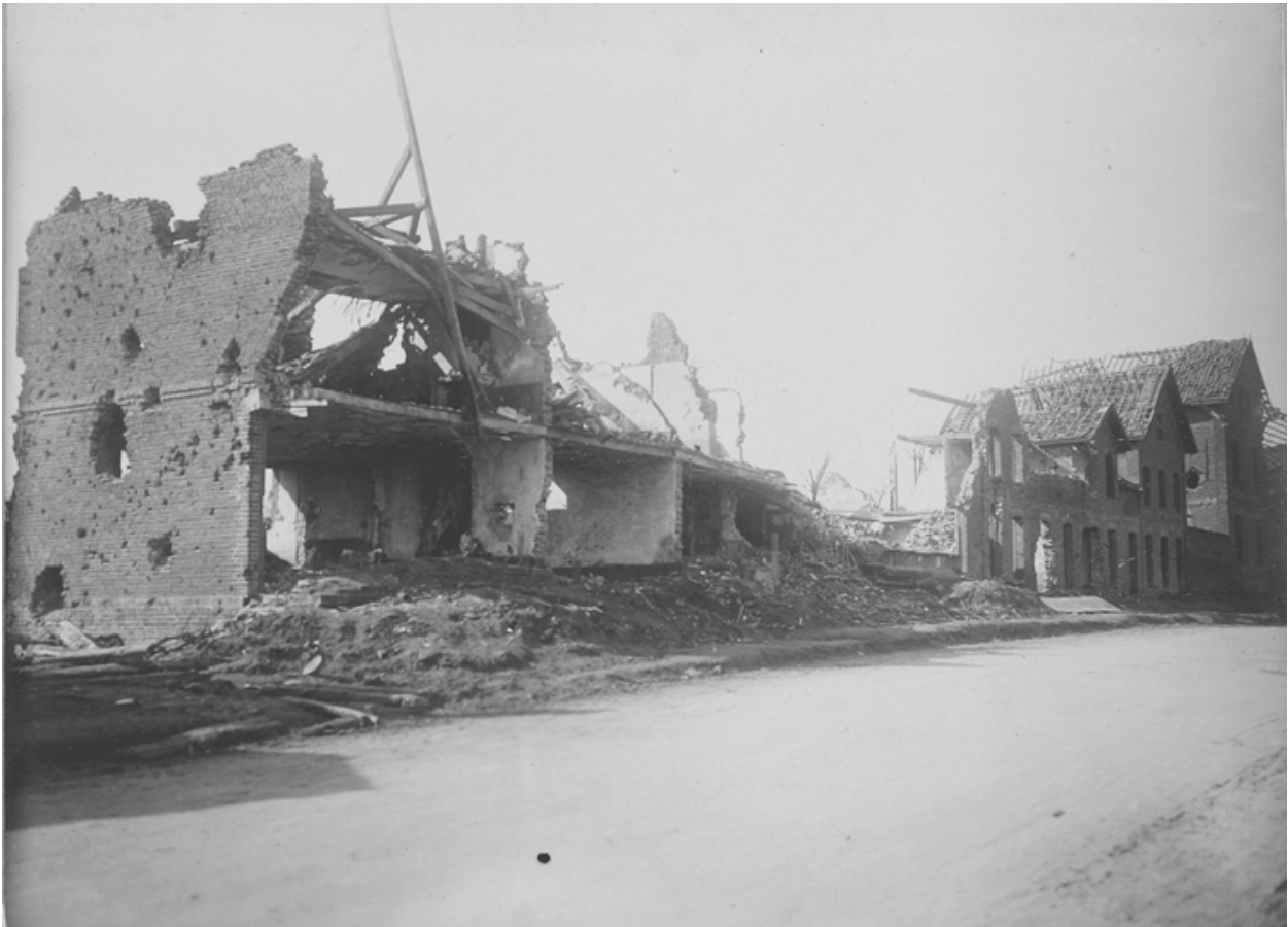
Ruines du premier groupe d'habitations jouxtant la cantine de l'usine, vers 1919 (AD Aisne).
