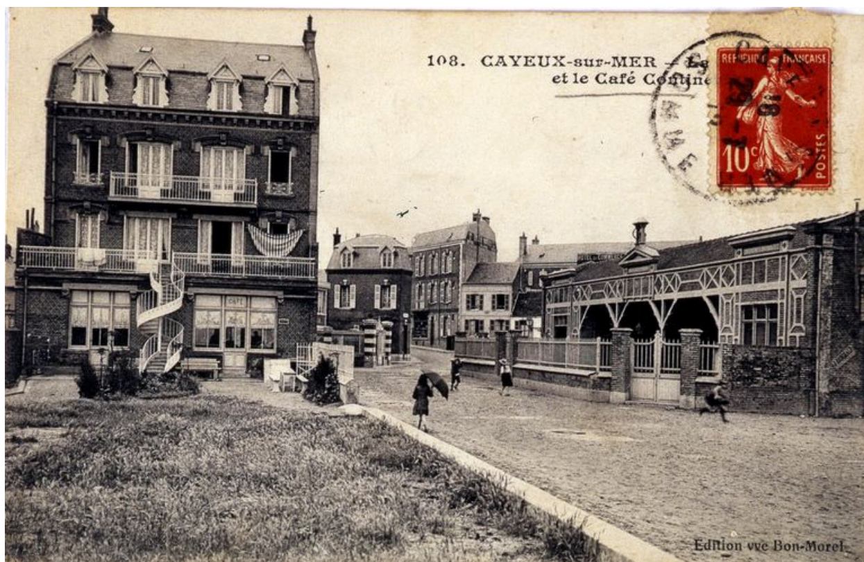
Le Café Continental (détruit) et les halles (détruites), carte postale, 1er quart 20e siècle (coll. part.).
