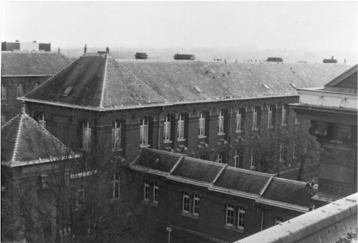
Vue aérienne des pavillons et d'une galerie de circulation couverte en 1989, avant les travaux de réaménagement et de destruction (coll. part.).
