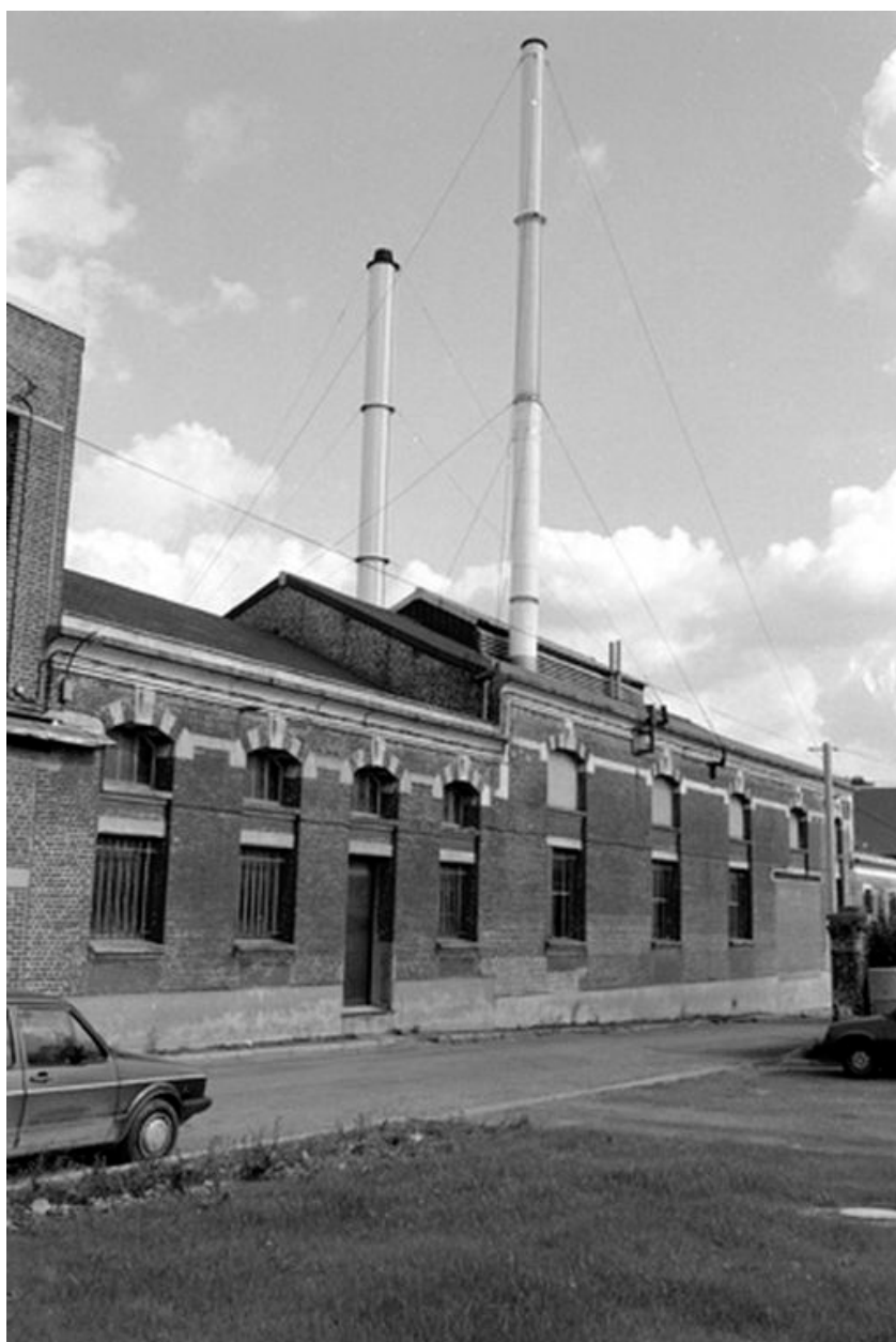
Chaudière, élévation antérieure.
