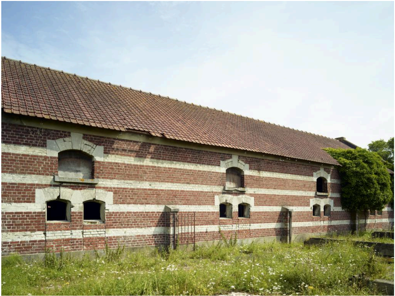
Façade longitudinale d'une des anciennes porcheries, vue partielle.
