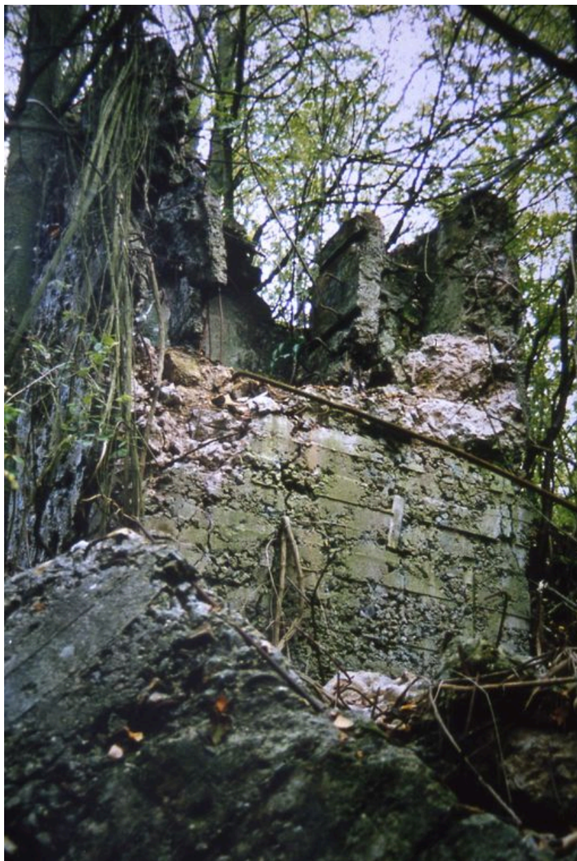
Vue actuelle de la tour en béton.
