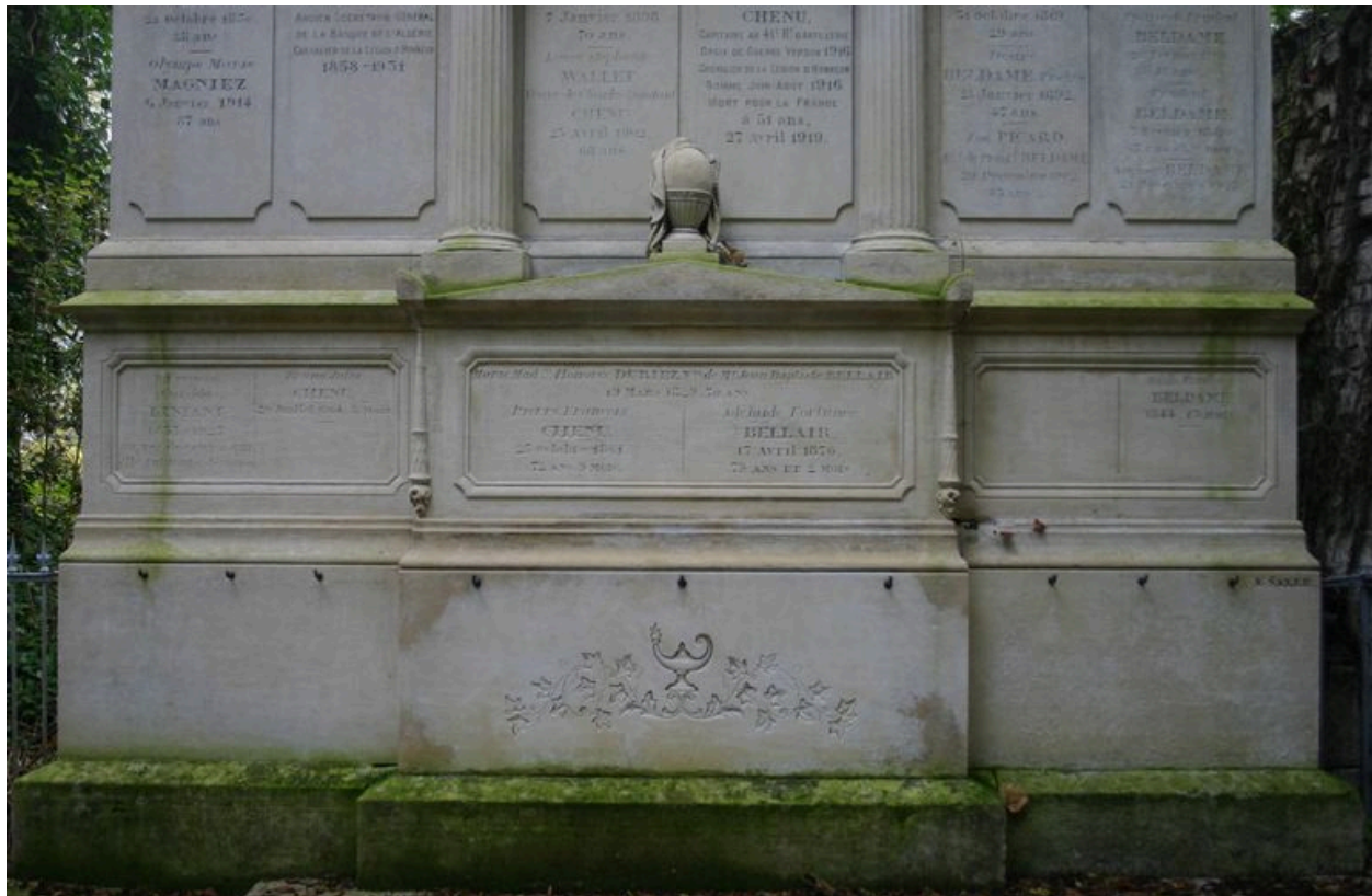
Détail de la base de la stèle architecturée.
