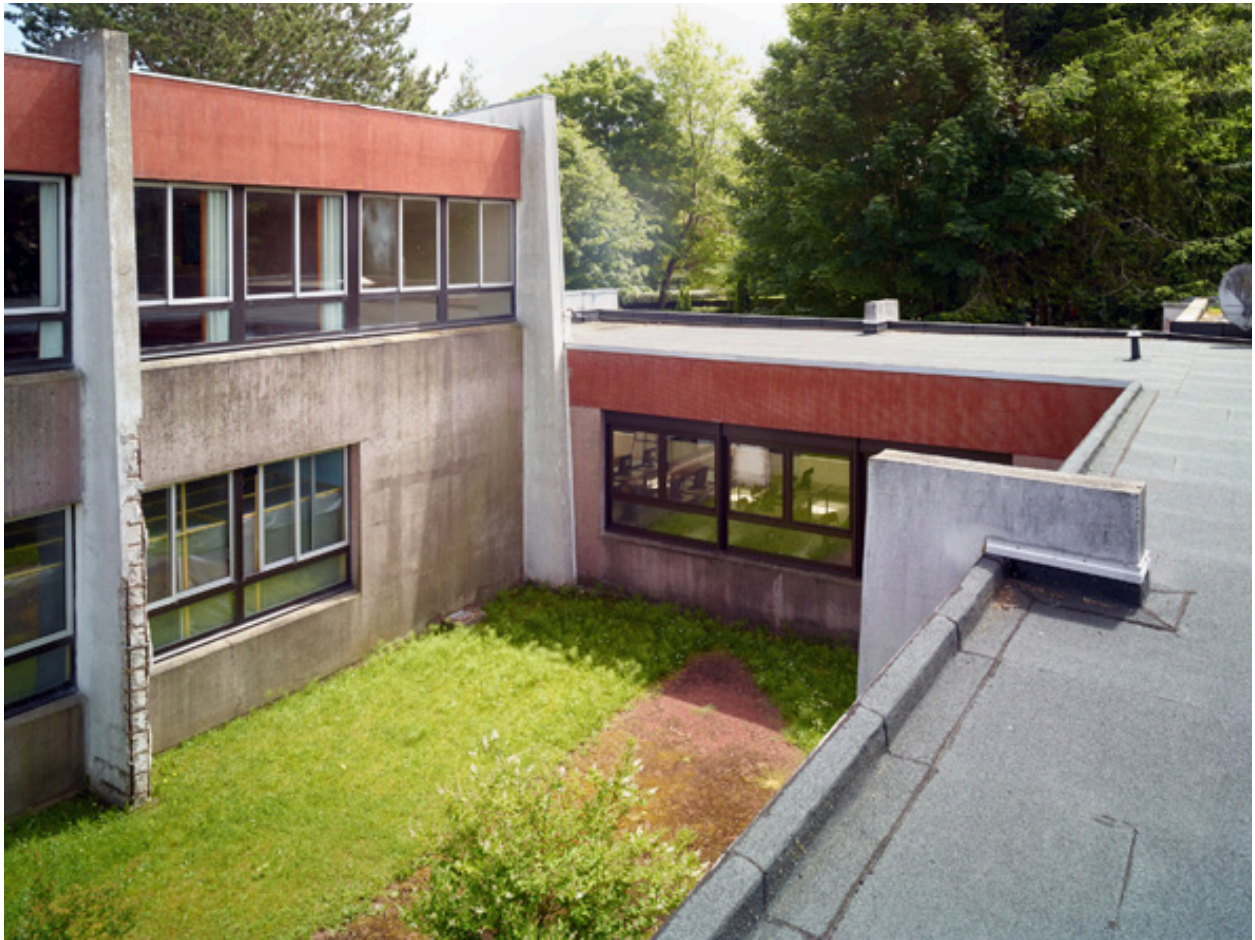
Terminaison du patio central vers le sud ouest, depuis la toiture du C.E.T.
