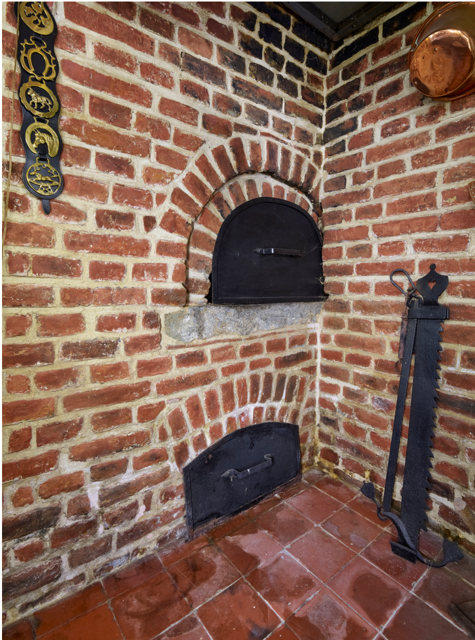
Détail du four à pain de la cheminée.
