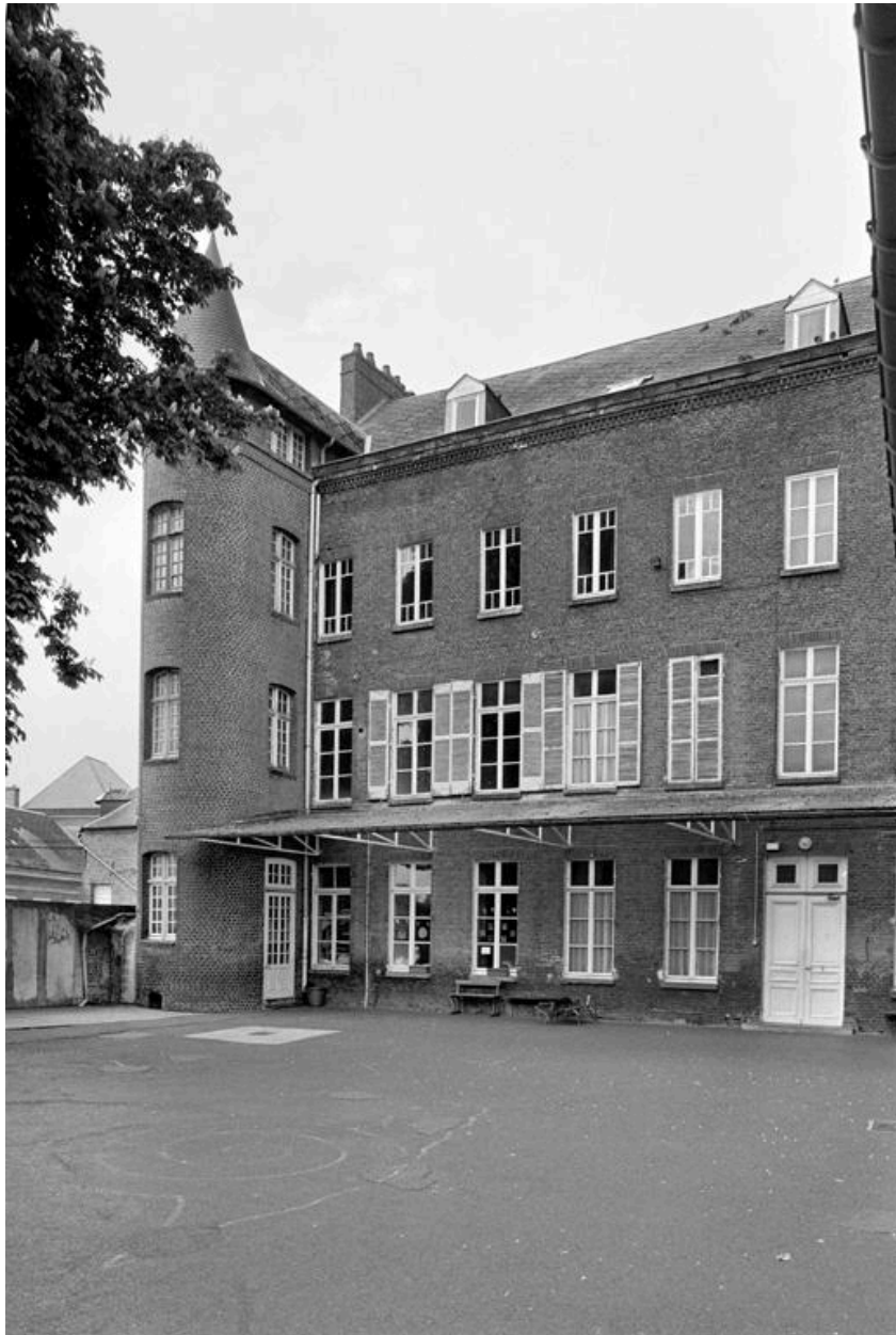
Vue de la façade sur la cour.
