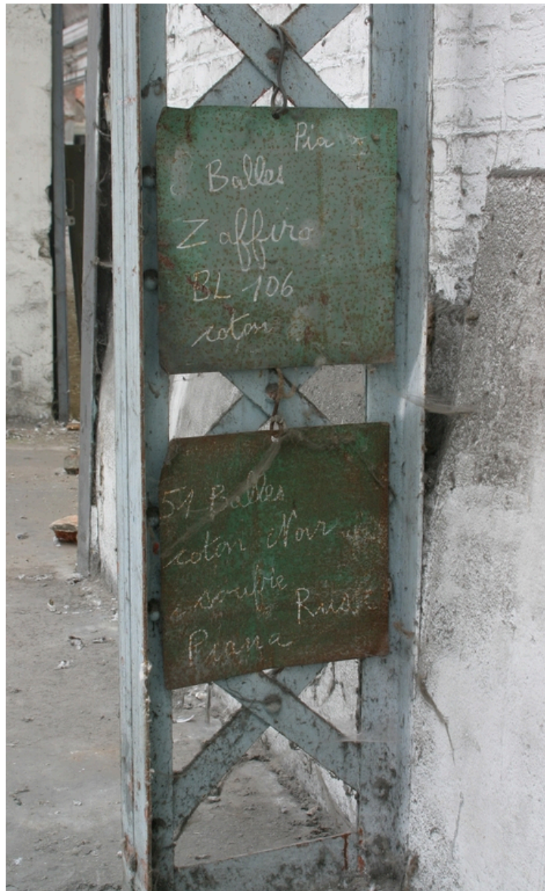
Entrepôt des matières premières : détail.
