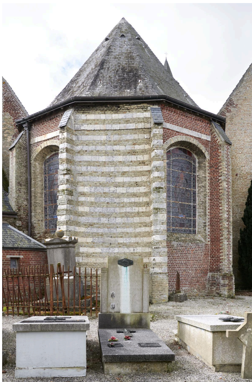
Chevet de l'église. Mur du chœur en "rouge-barre".
