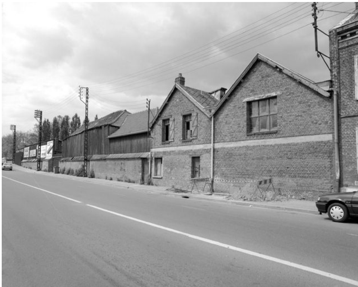
Vue générale de la scierie, flanc sud.
