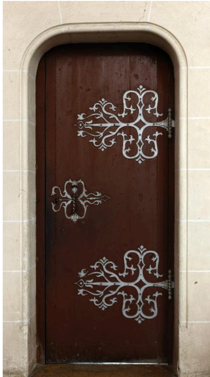
Porte de la sacristie dans une arcade du mur sud du chœur.
