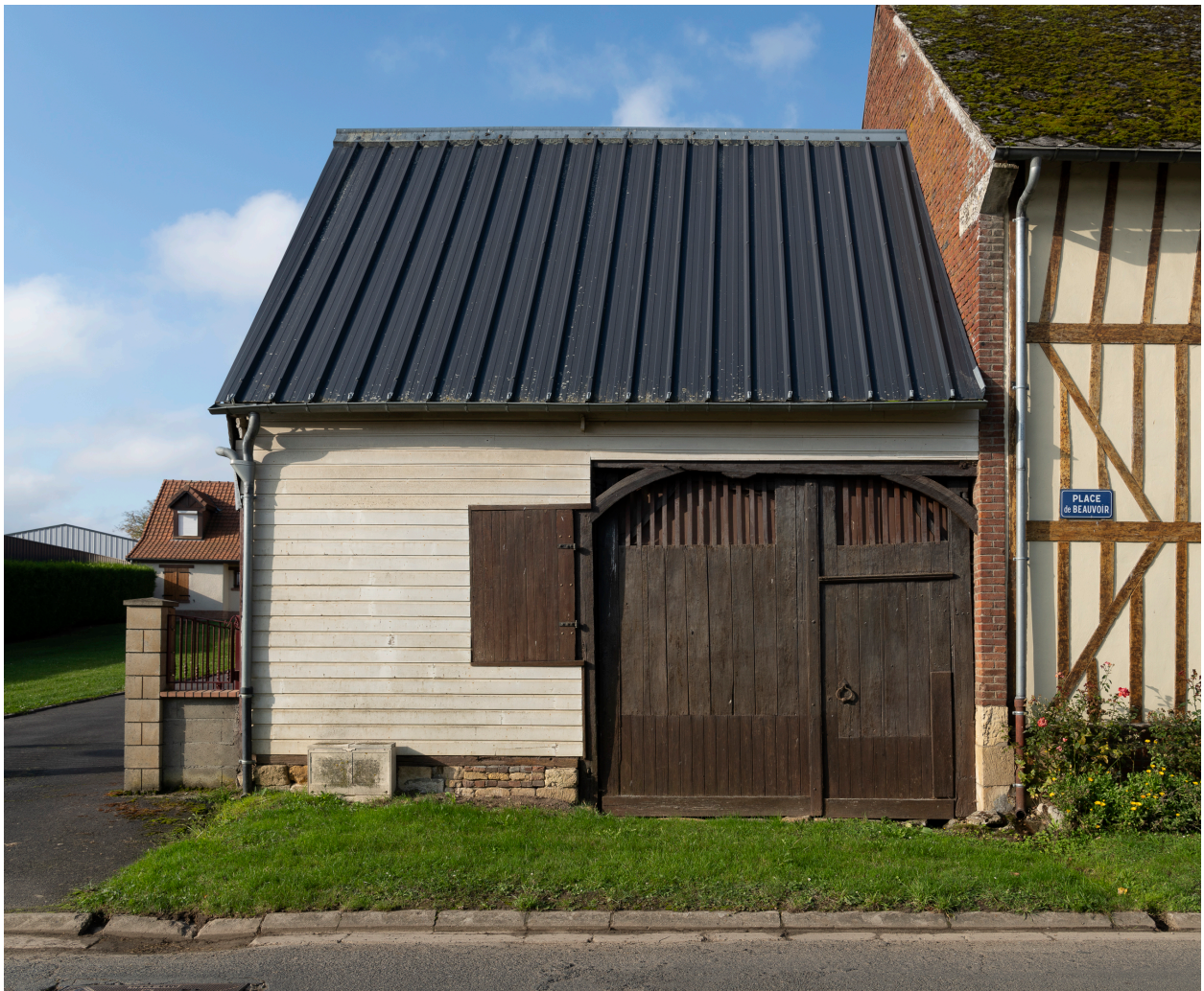
Grange avec grand'portes et porte à engranger, n°6 de la place de Beauvoir, vue depuis l'est.
