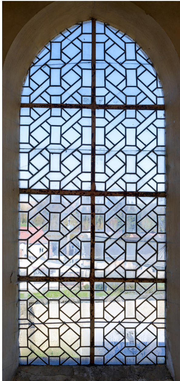
Verrière (baie 5) : verrière à borne.
