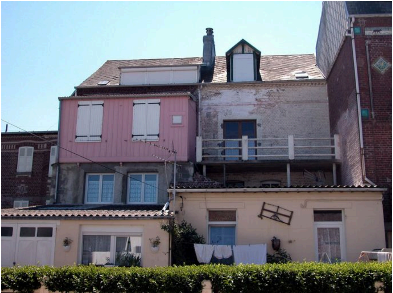
Vue d'ensemble sur la façade postérieure, côté mer.
