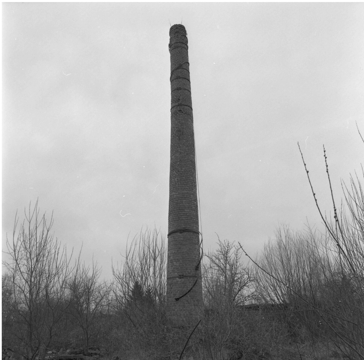
Cheminée d'usine, état en 1996.
