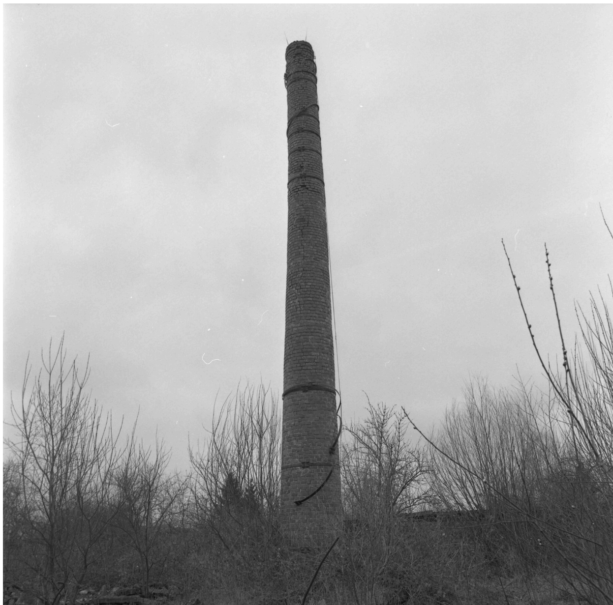
Cheminée d'usine, état en 1996.
