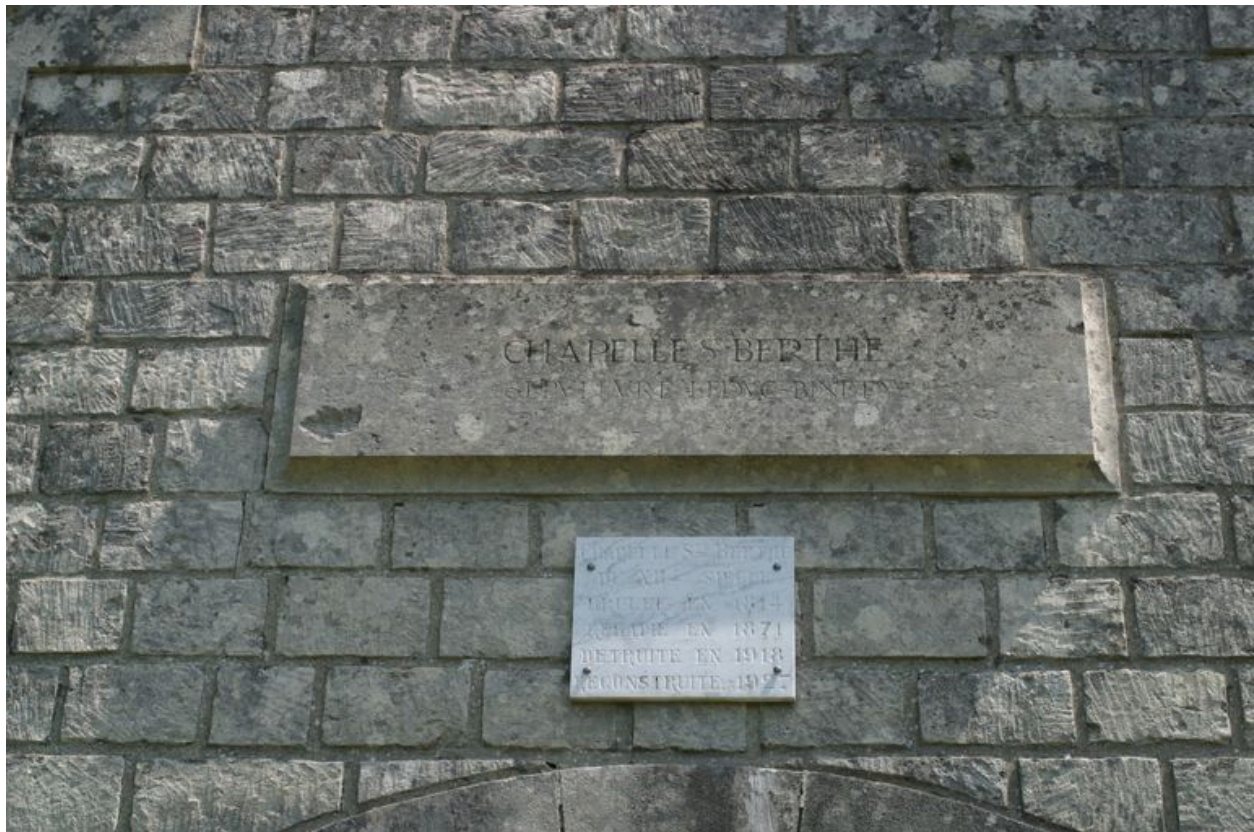
Vue d'une plaque fixée au mur latéral gauche.
