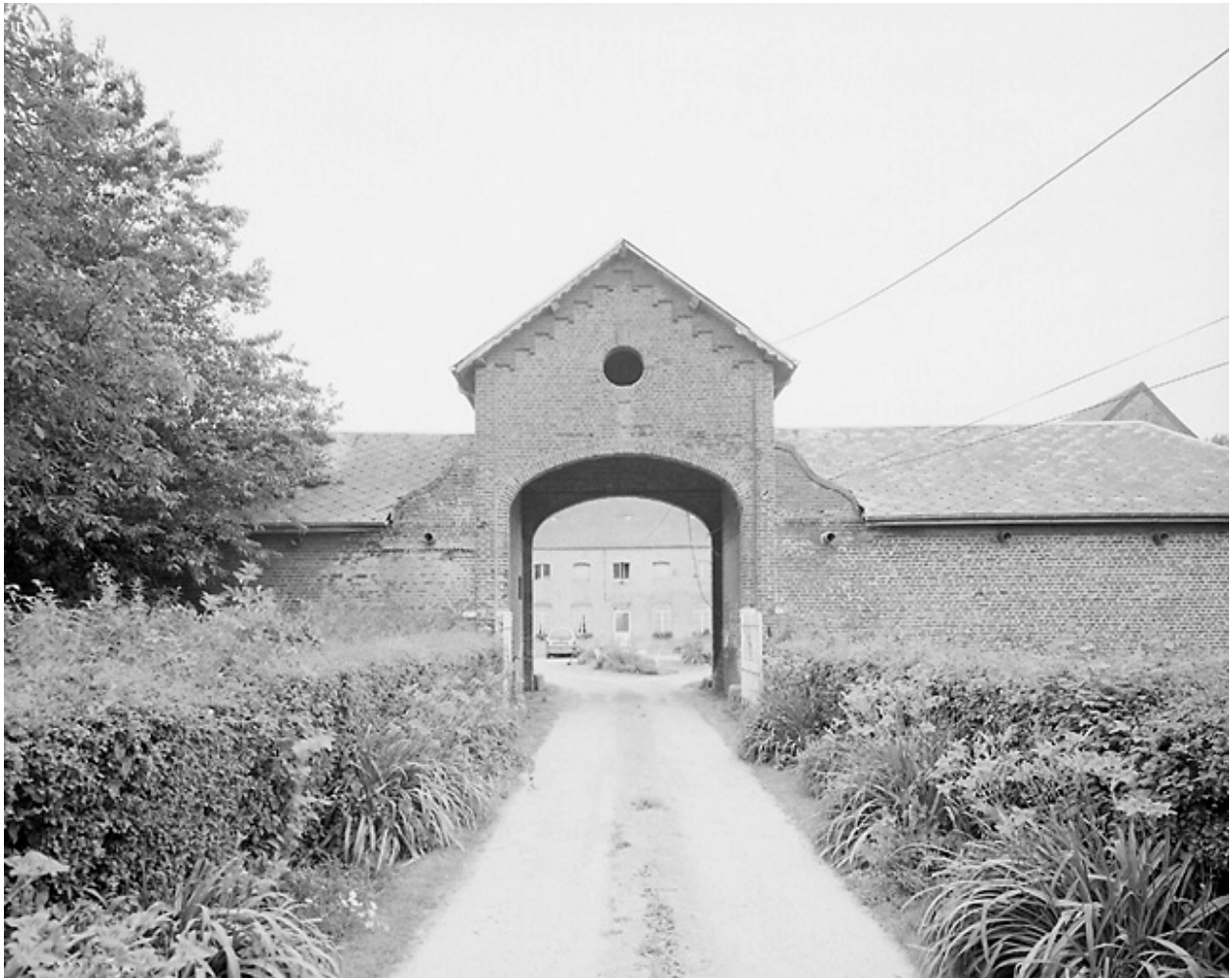
Vue générale du porche d'entrée.
