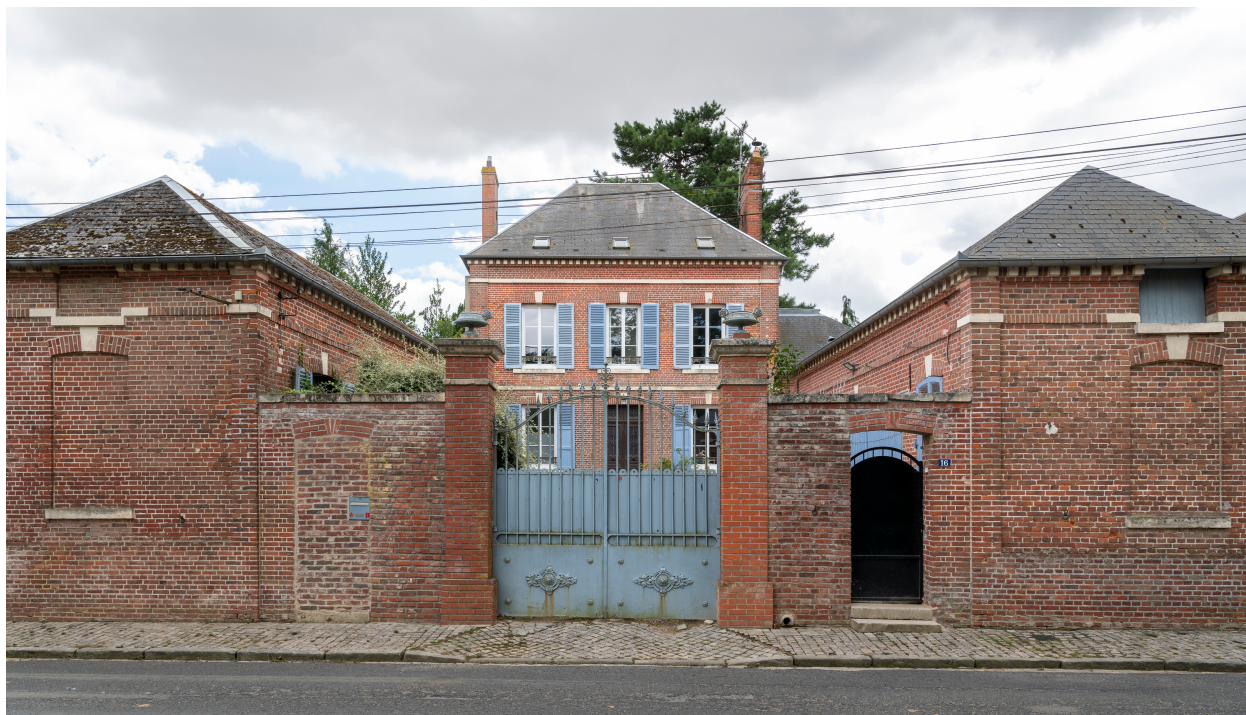
Demeure, n°16 de la rue du Bail, vue depuis le nord.
