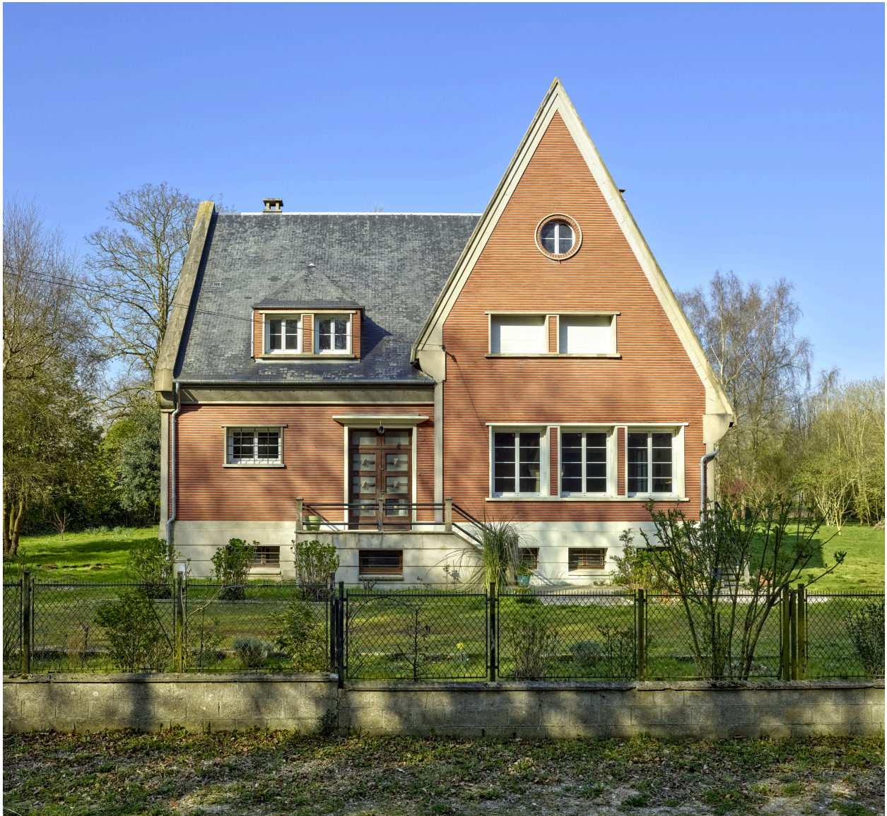
Vue de la maison, depuis l'est.
