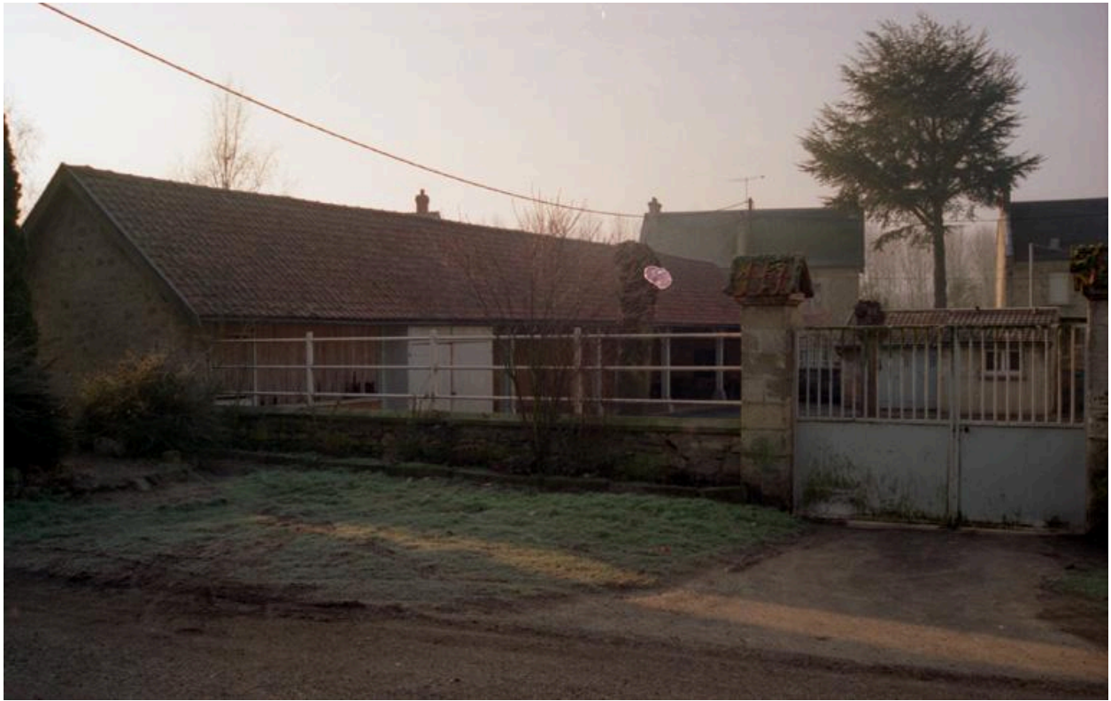
Vue du préau et des toilettes, situés au fond de la cour.
