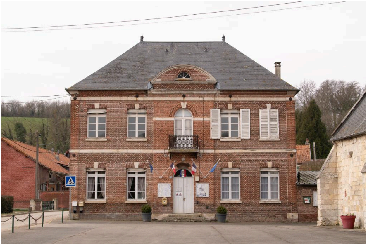
Mairie-école vue depuis l'est.
