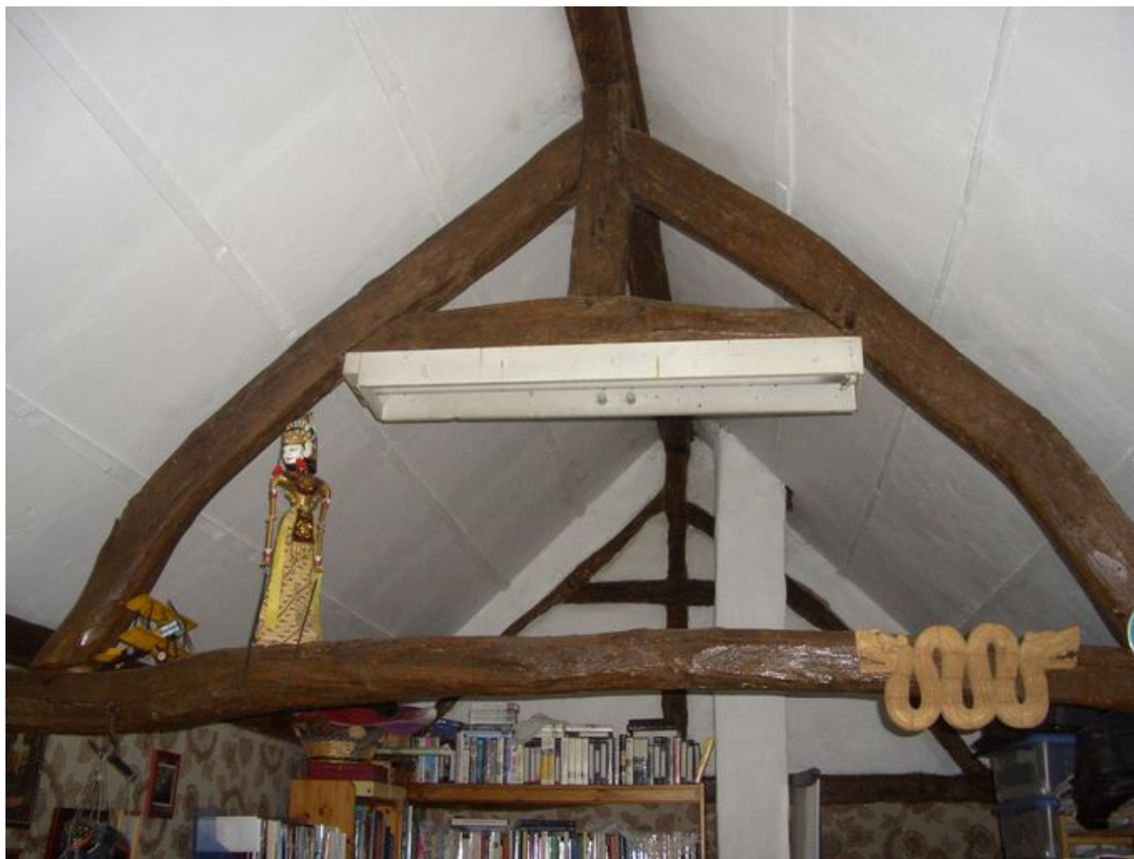
Vue de la charpente de l'annexe.
