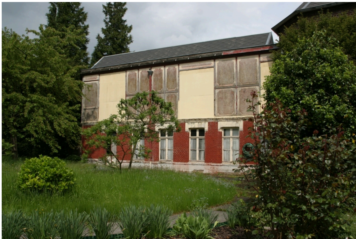
Façade antérieure du logement patronal : cuisine et buanderie (rez-de-chaussée), bibliothèque et studio, en 1914.
