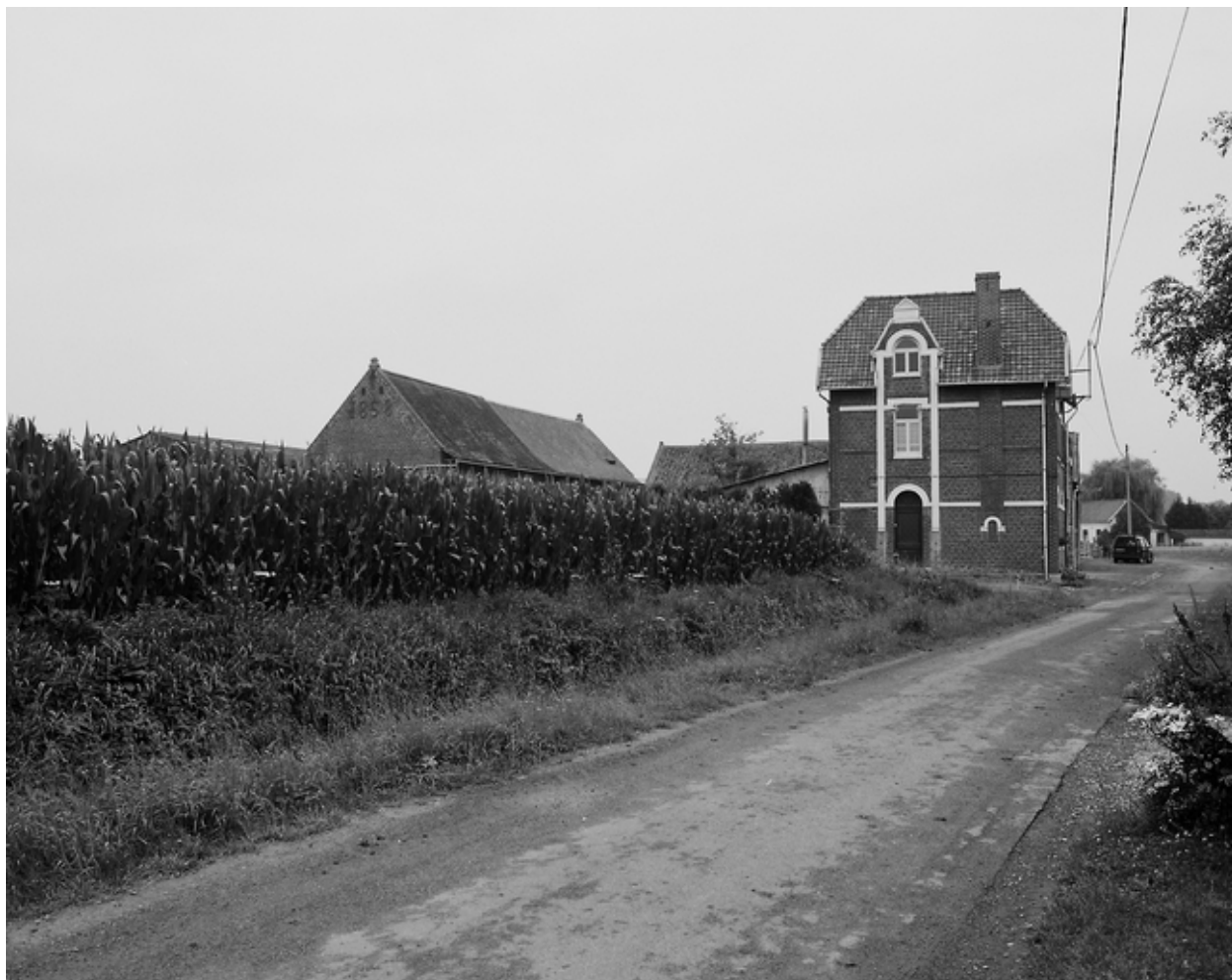
Vue générale latérale : logis reconstruit et grange.
