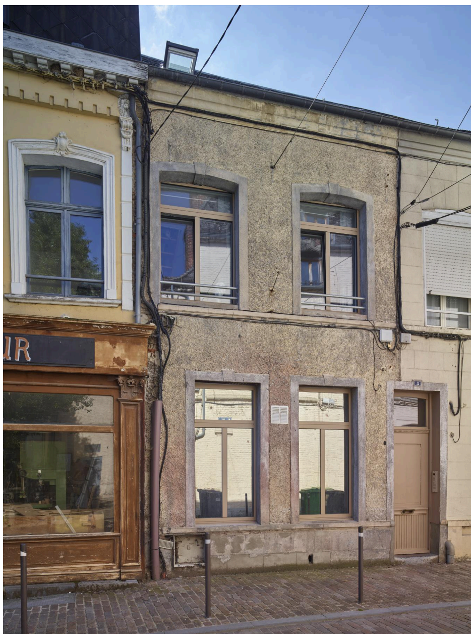
Maison, 5 rue Théau : façade entièrement enduite en nid d'abeille.
