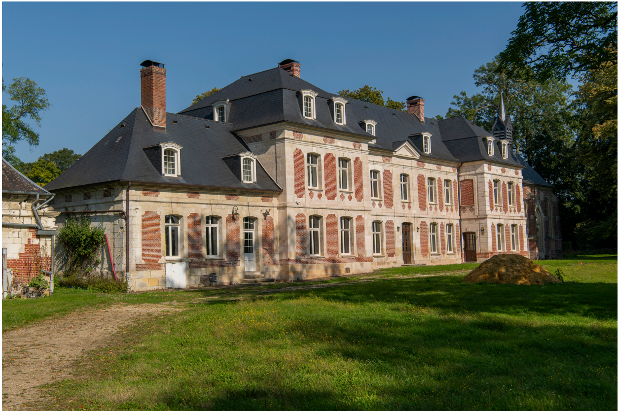
Château vu depuis le sud-est.
